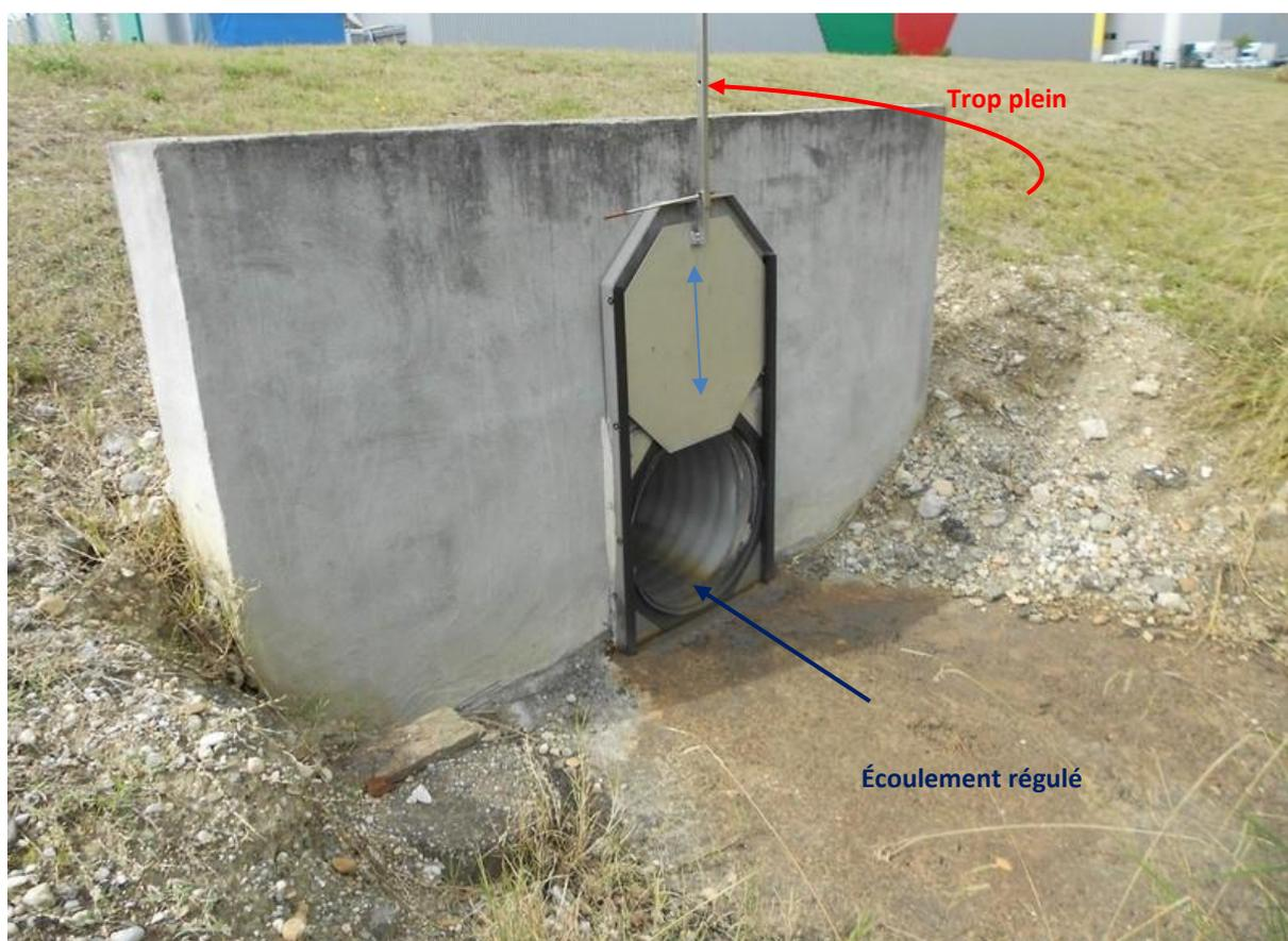
Figure 9 : Principe de l'ouvrage de régulation – type vanne murale
