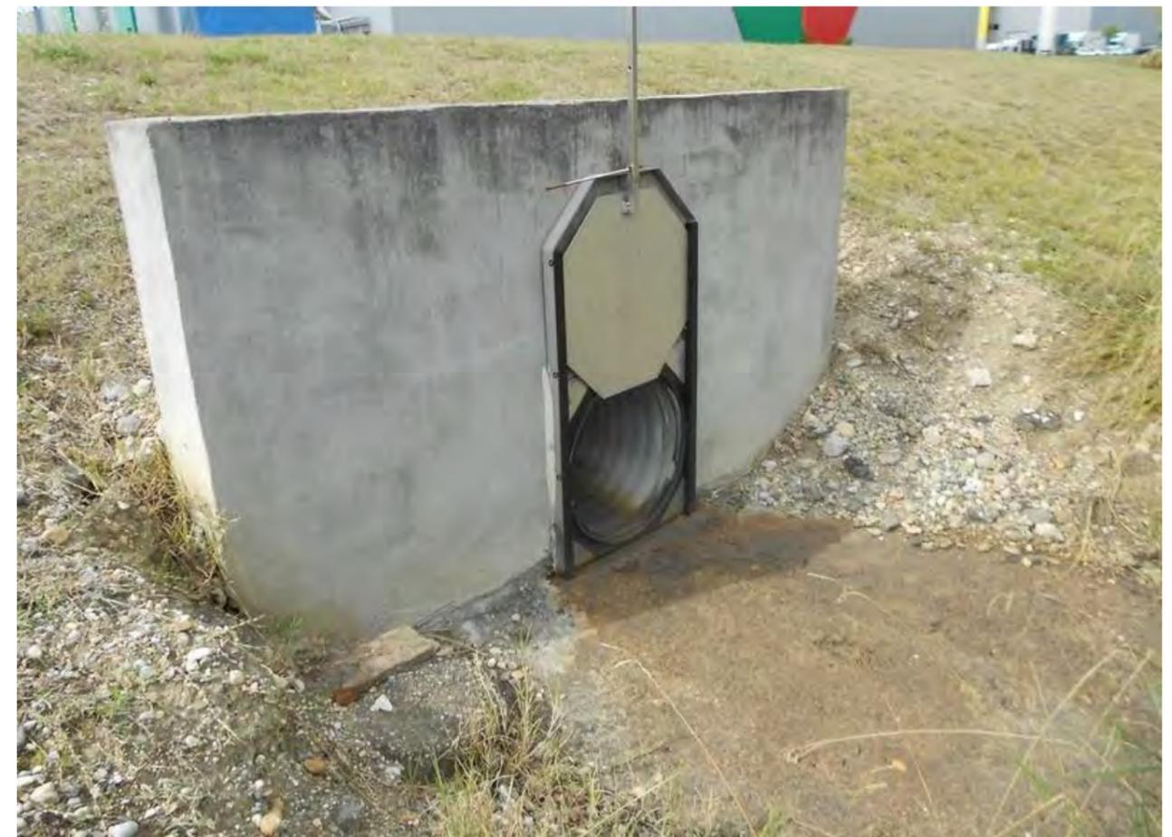
Figure 40 : Principe de vanne murale à mettre en place
