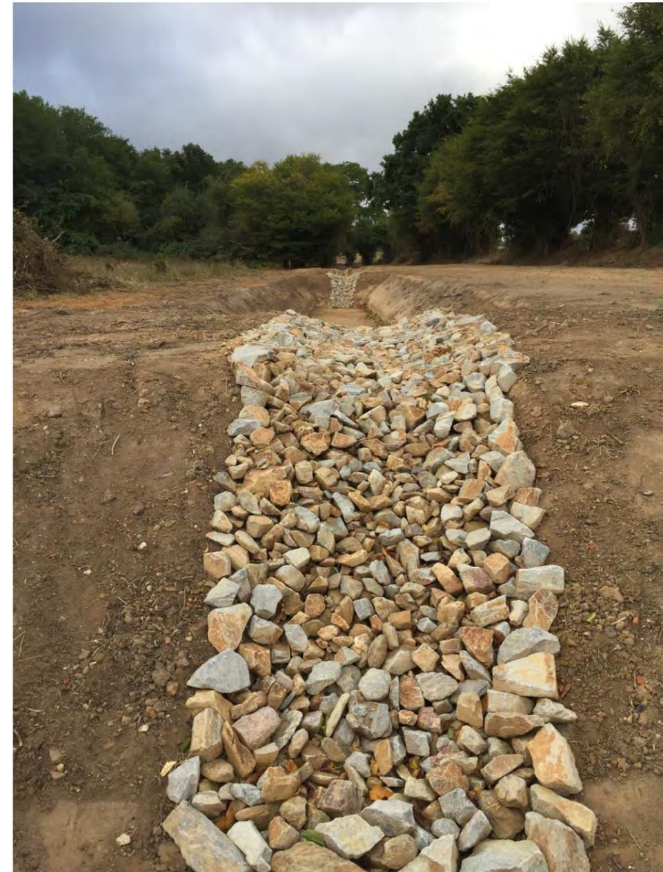
**Photo 41 : Exemple de fossé à redent – au niveau de la surverse entre deux tronçons**
