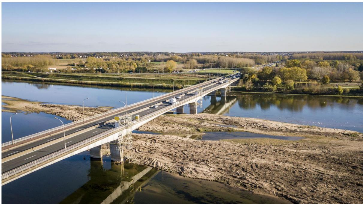
Long de 412 mètres et large de 21 mètres, le pont Charles-de-Gaulle pose sa silhouette au-dessus de la Loire entre Blois et Vineuil depuis 1970. Composé d'une structure de [caissons](#) en [béton précontraint](#), le tablier comprend 5 travées longues de 61,50 à 91 mètres.
