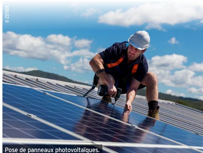
Pose de panneaux photovoltaïques.
