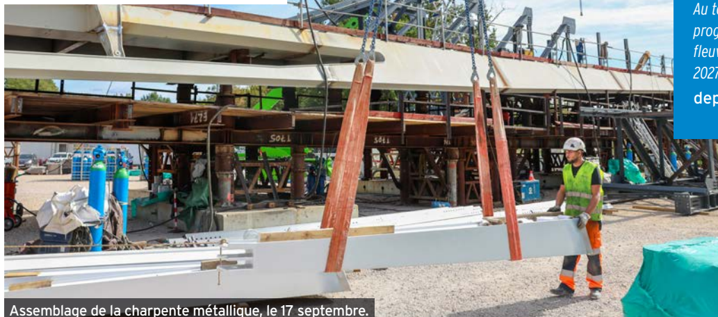
Assemblage de la charpente métallique, le 17 septembre.
