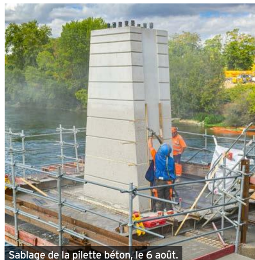
Sablage de la pilette béton, le 6 août.
