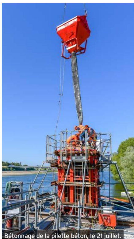
Bétonnage de la pilette béton, le 21 juillet.
