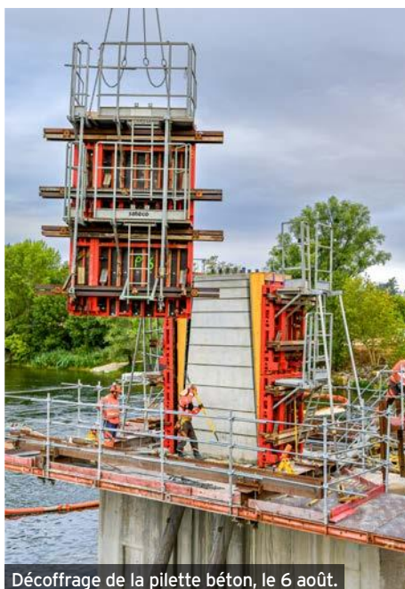
Décoffrage de la pilette béton, le 6 août.
