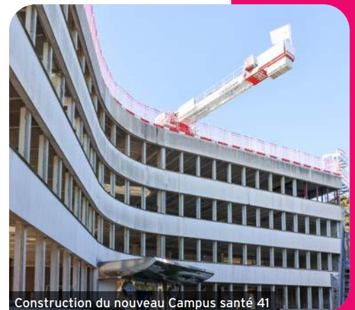
Construction du nouveau Campus santé 41
