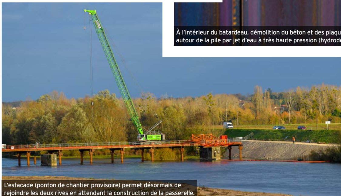
Enceinte étanche (batardeau) permettant le travail à sec sur les piles.
