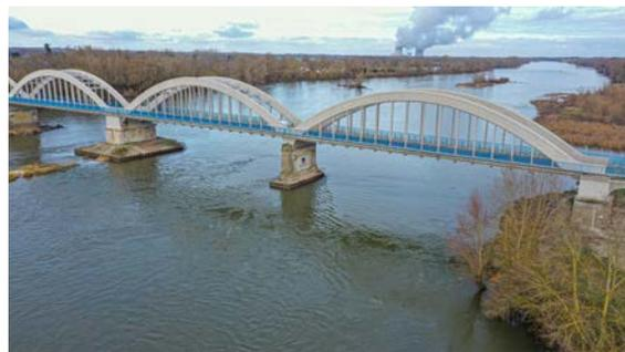
Ce chantier concerne les deux ouvrages d'art créés en 1930, d'une longueur totale de 330 m, qui relient Mer et Muides-sur-Loire. Débutés fin 2020, les travaux seront finis en mars. Coût de cette réparation ou « *lifting* » : 1,8 M€.
